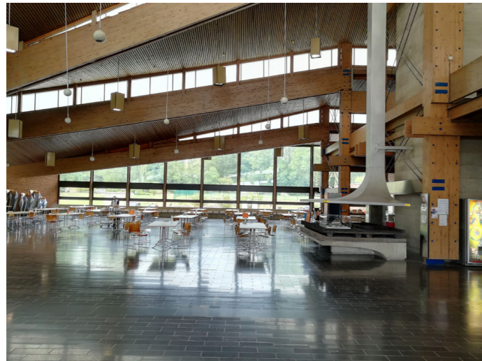
Img. 08 Réfectoire existant avec ses structures en acier bleu
