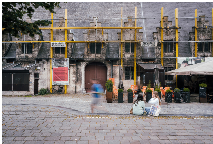
fig.3 La Grande Boucherie dans l'échafaudage © Ville de Gand, photo: Rosan Steenbrugge
