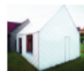
utilisation originale d'un matériau traditionnel: ardoises transformées en polycarbonate, sur structure bois
