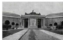
Prospective centrale vers la façade monumentale Victor Horta
